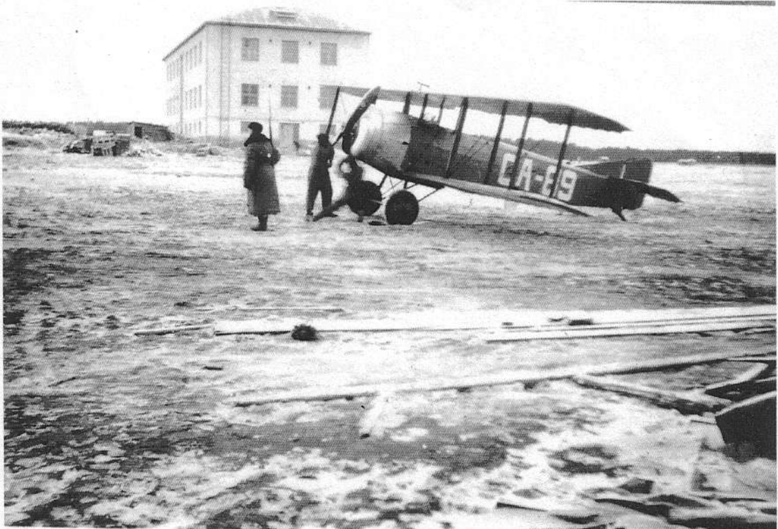
Ensimmäistä Caudron-konetta valmistellaan lennolle keskellä rakennustyömaata. Kuva: Timo Nieminen
